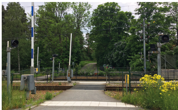
Plankorsning för gång och cykel öster om stationsplattformen utgör en viktig länk mellan den norra och den södra sidan av järnvägen.
